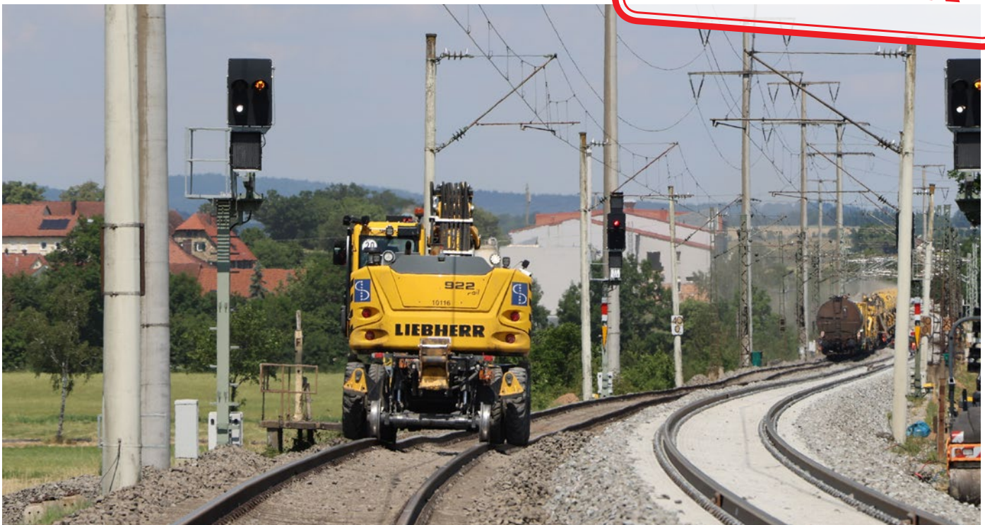
Abb. 5: Vergleich zwischen bereits erneuerter und noch nicht erneuerter Strecke
