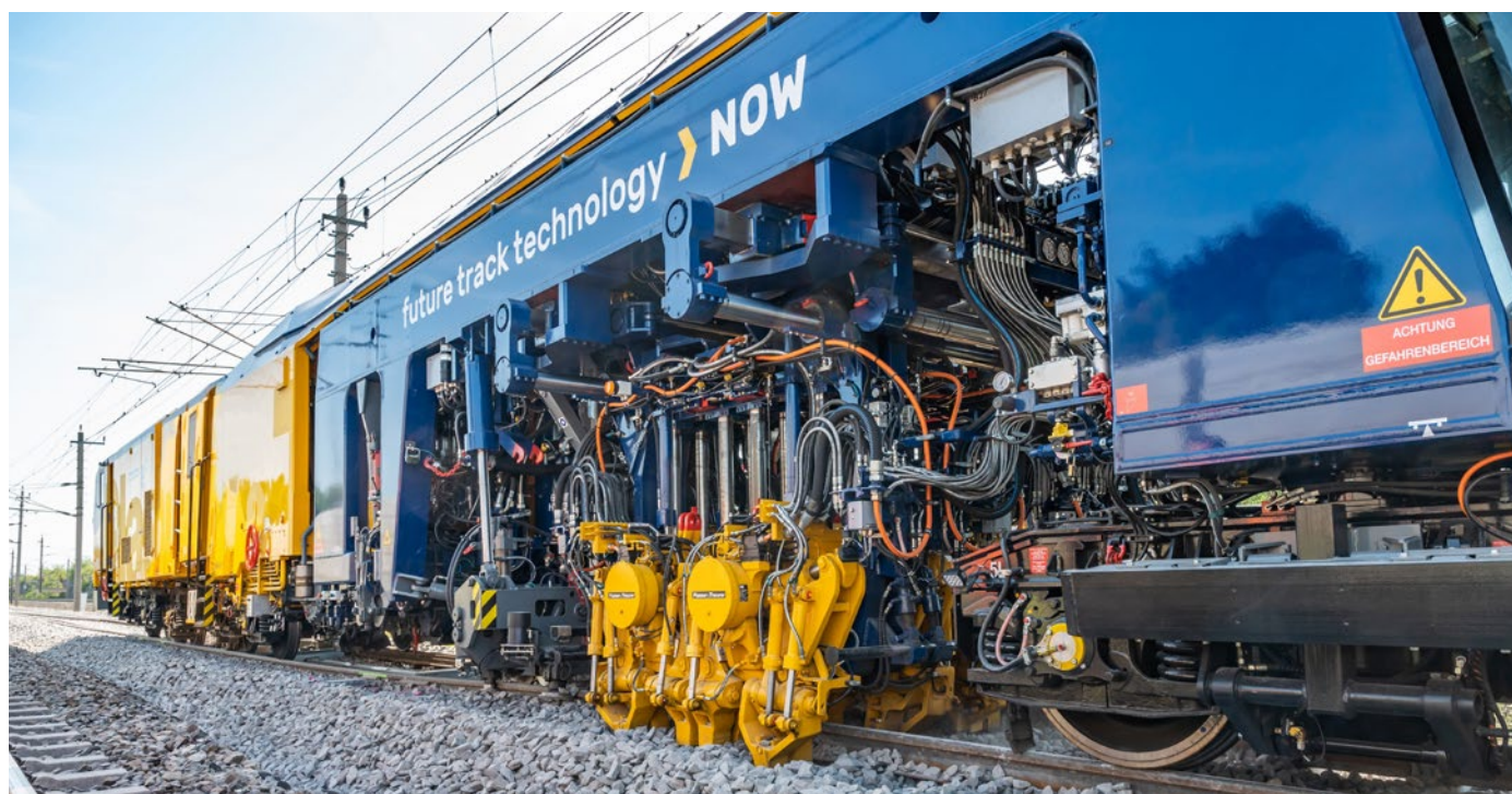
Abb. 1: Elektrisch angetriebene Stopfmaschine mit integrierten Zusatzfunktionen wie Schotterplanierung und dynamischer Gleisstabilisation
