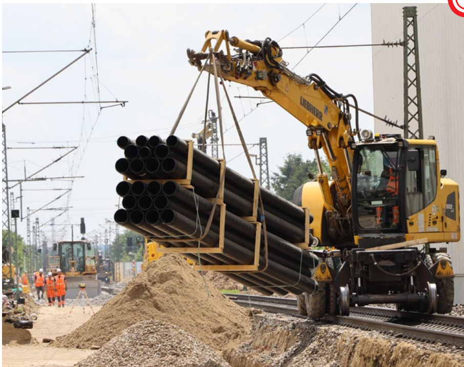
Abb. 3: Transport für den TE-Neubau vorgesehener Rohrsegmente
