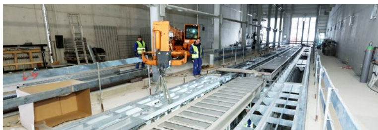
Abb. 14: Straßenbahn-Hebeanlage im Bau.
