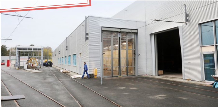
Abb. 15: Außenansicht der Halle für die Radsatzbearbeitung.
