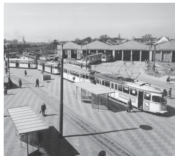
Abb. 2: Nach dem Ende der 1950er Jahre erfolgten Wiederaufbau behielt der Betriebs- hof Gröpelingen für mehr als 60 Jahre seine Form. Im Vordergrund die Umsteigeanlage. Damals fuhr noch der Obus und der Dampf im Hafen (Hintergrund) ist Zeichen für das Wirtschaftswunder. Foto: BSAG
