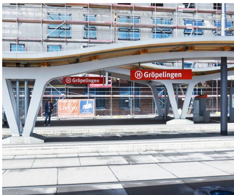
Abb. 20: Die Bahnsteige mit den gewellten Überdachungen.
