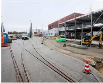
Abb. 7: Weichenstraße von den sieben Abstellgleisen plus Umlaufgleis zur Ausfahrt (Blick Richtung Norden). Foto: BSAG / Martin Rospek
