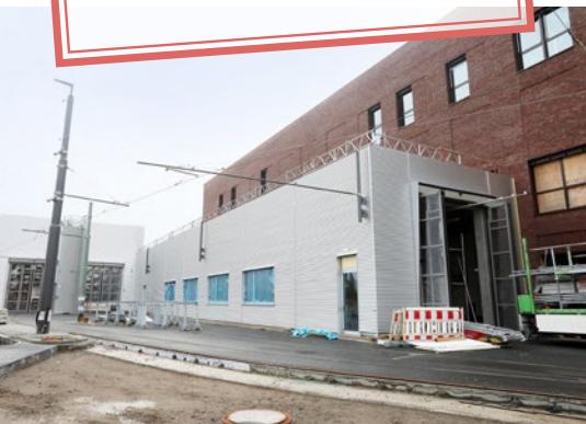
Abb. 9: Einfahrt zum Gleis für die Durchlaufwartung. Links die erkennbar höhere zweigleisige Werkstatthalle, rechts das Polizeigebäude.
