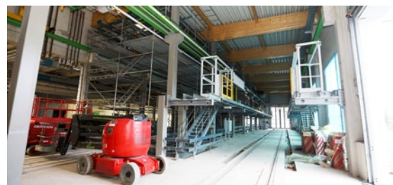
Abb. 13: Blick in die Werkstatthalle, rechts Arbeitsstand für Klimawartung, links entsteht der Instandsetzungsstand.
