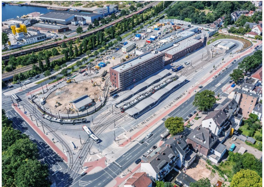
Abb. 3: Luftansicht der Umsteigeanlage aus Osten gesehen im Bauzustand von Mitte August. Der Betriebsbahnhof liegt hinter der Umsteigeanlage, im Hintergrund befinden sich die Hafenanlagen. Gut zu erkennen ist links vom Polizeigebäude der Lärmschutzzaun entlang des inneren Wendegleises.
